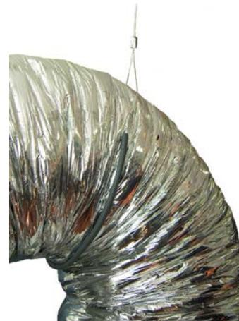
11) Den Draht mit der Öse am anderen Ende des Drahtes an der Decke befestigen.
