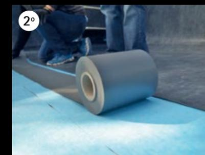
2° Stendere il nastro per saldatura di testa sulla zona esatta in cui è previsto realizzare la saldatura della membrana, cercando di fare in modo che si realizzi al centro del nastro.
