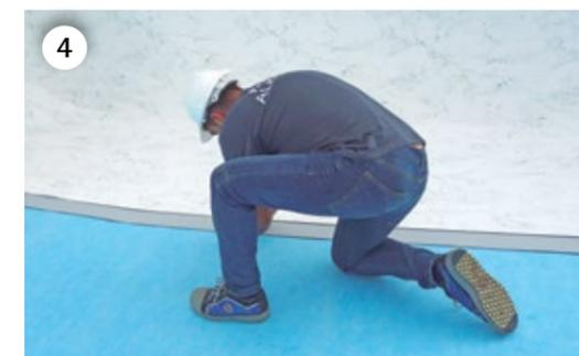
In caso di saldature di testa, dopo aver collocato il geotessile ritagliare ed eliminare il materiale nel punto in cui si sistemerà il nastro della saldatura di testa e dove si effettuerà la saldatura.
