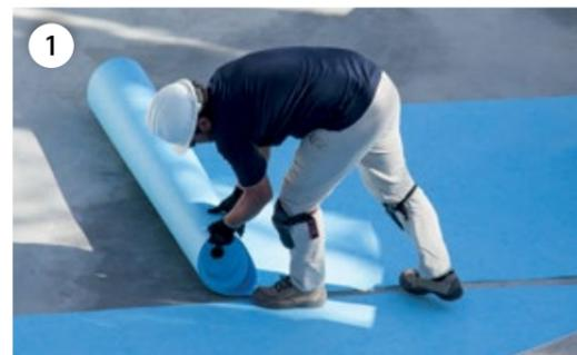
Prima di collocarlo, pulire bene il pavimento della piscina eliminando totalmente eventuali pietre, asperità o qualsiasi altra irregolarità. Si raccomanda che il pavimento sia il più asciutto possibile per evitare l'eccesso di umidità.
