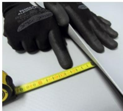
Collocare le 2 membrane da saldare lasciando una sovrapposizione di circa 5 cm e verificando che entrambe siano nella posizione esatta in cui vogliamo saldarle, in modo che non si muovano durante la saldatura.
