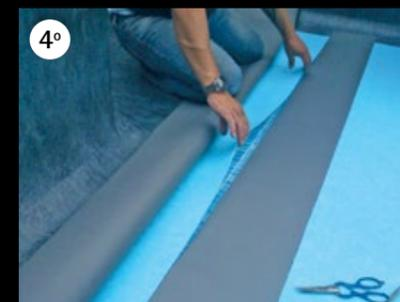
4° Introdurre il nastro per saldatura di testa in questo spazio e incollarlo.
