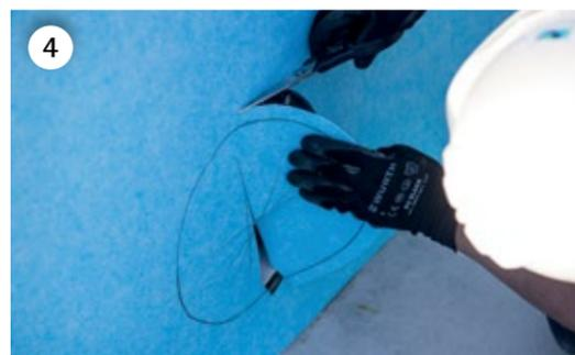
Dopo aver installato il geotessile, ubicarlo nella zona degli accessori della piscina e tagliare il pezzo di geotessile che li nasconde lungo suo perimetro esterno.
