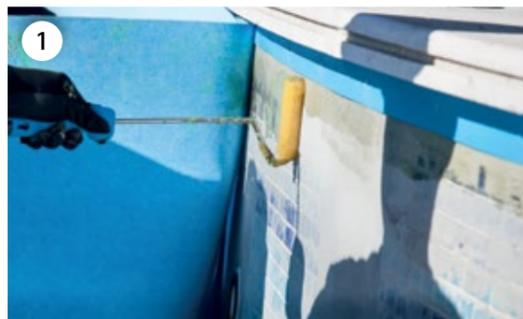
Applicare **RENOLIT ALKORGLUE** colla di contatto a base di neoprene sulla parete, in uno spazio di 20 cm., giusto al di sotto del profilo di sostegno, evitando di macchiarlo. Successivamente applicare la colla anche sulla parte da far aderire al geotessile e far seccare fino all'evaporazione dei solventi.
