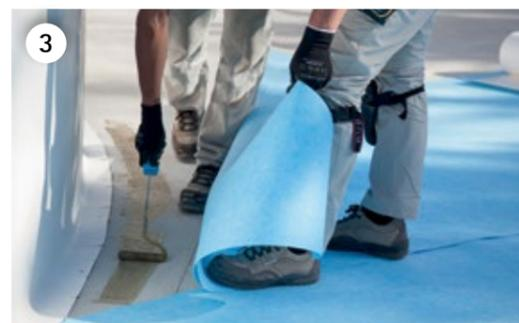
Fissarlo al pavimento applicando colla di contatto **RENOLIT ALKORGLUE** perché si tratta di un materiale molto leggero e il vento potrebbe sollevarlo o spostarlo. Far asciugare la colla di contatto sotto il geotessile prima di cominciare a installare la lamina.
