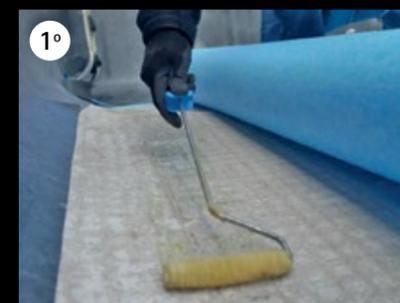
1° Coprire completamente il pavimento della piscina con il feltro geotessile fissandolo al pavimento con colla a contatto lungo le estremità. Stendere successivamente la membrana armata per calcolare dove si realizzeranno le saldature.
