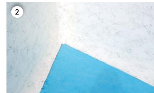
Tagliare il geotessile a seconda delle dimensioni della zona del pavimento facendo in modo che venga apposto né sulla lamina né su altro geotessile.
