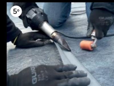
5° Saldare la membrana al centro del nastro per saldatura di testa con una saldatura doppia (interno-esterno).
