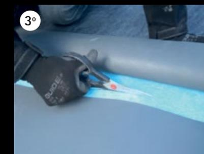
3° Segnare sul feltro geotessile la parte da tagliare, con una matita o con un tiralinee, dove si collocherà il nastro per saldatura. Togliere il nastro per saldatura di testa e tagliare il feltro geotessile.
