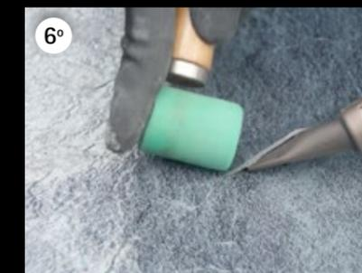
6° Collocare la seconda membrana vicino alla prima senza sovrapporle e saldarla con saldatura doppia. Rfinire la saldatura riscaldando un rullo di ottone sigillando l'unione.
