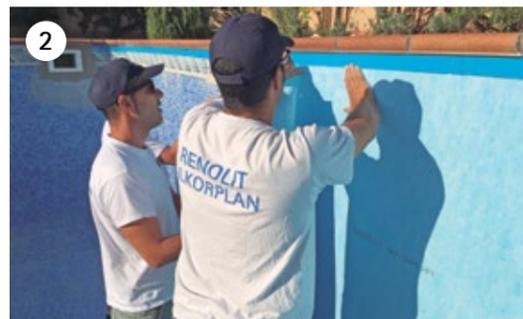
Installare il geotessile **RENOLIT ALKORPLAN** al di sotto del profilo di sostegno, esercitando pressione sulla zona incollata. Accomodare il geotessile alla forma della parete esercitando pressione con le mani per evitare che si formino rugosità.
