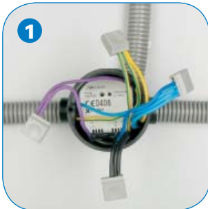
1 Der Actor wird in der UP-Dose eingebaut und angeschlossen
