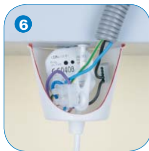
6 Einbau des Aktors in Lampenabdeckung
