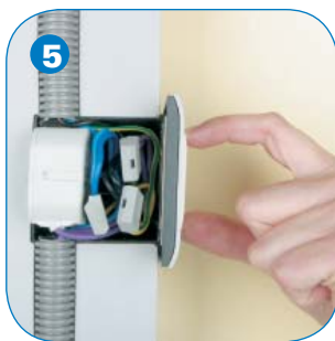
5 Einbau des Aktors in Schalterdose mit Funktaster als Kombinationslösung
