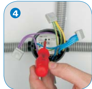
4 Die Programmier Taste wird nochmals gedrückt, um den Vorgang abzuschließen (die LED und die angeschlossene Lampe sind AUSgeschaltet)
