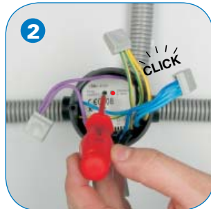
2 Die Programmier Taste wird betätigt (die rote LED und die angeschlossene Lampe sind EINGeschaltet)
