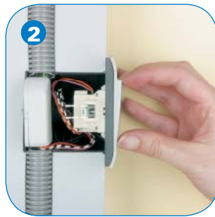
2 Integration konventioneller Schalter mit Binäreingang in das Funksystem
