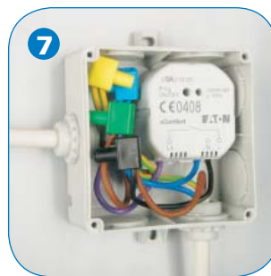
7 Einbau des Aktors in Feuchtraumdose
