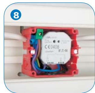
8 Einbau des Aktors in Kabelkanaldose
